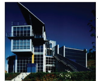
Außenansicht des Instituts für Solarenergieforschung
