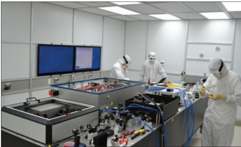
Installation des stabilisierten 200W Lasersystems am Advanced LIGO Gravitationswellendetektor in Hanford (USA)
